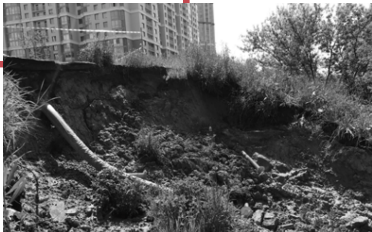
Рисунок 21. Активизация оползневого процесса вблизи школы по адресу ул. Мосфильмовская, д.88к5 в июне 2020 года (участок Раменка-5)
