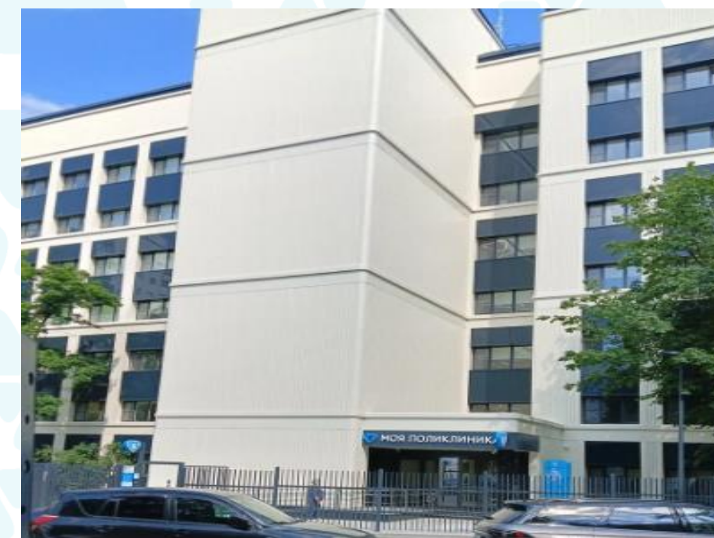
Филиал №1 Москва, Ореховый бульвар, д.35, к.2 Открытие после капитального ремонта 09.06.2025 прикрепленное население – 66634 человек
