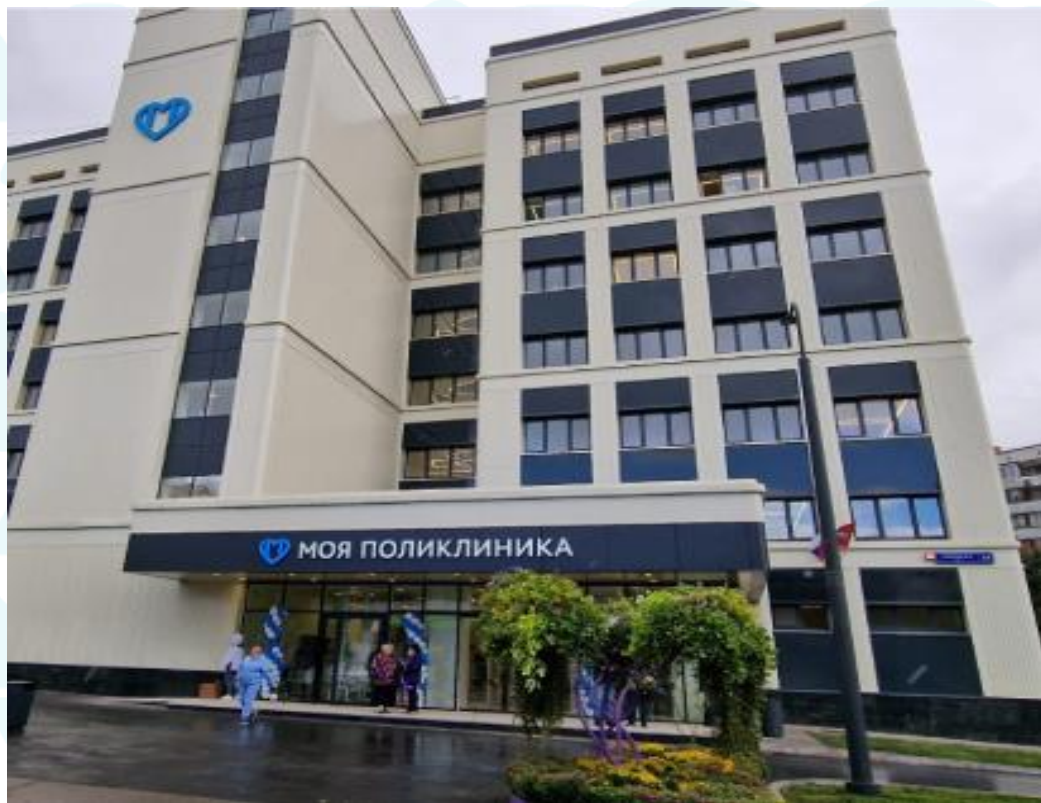
Главное здание ГБУЗ «ГП №214 ДЗМ» Москва, ул. Елецкая, д.14 Открытие после капитального ремонта 08.09.2023 прикрепленное население – 64855 человек
